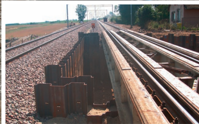
Fot. 3. | Scianka zabezpieczająca torowisko – KLCS Tczew
