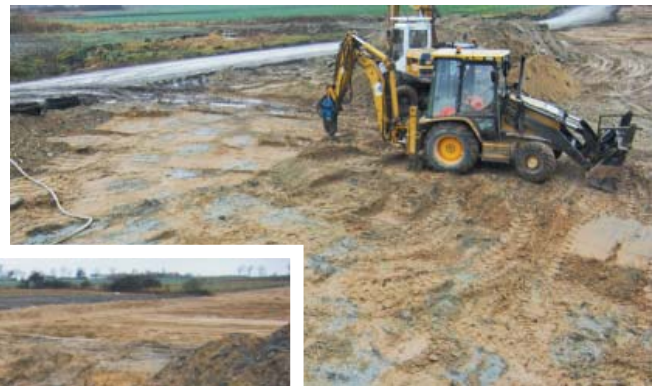
Fot. 4, 5. | Ułożenie chudego betonu na wcześniej wykonanych kolumnach DSM
