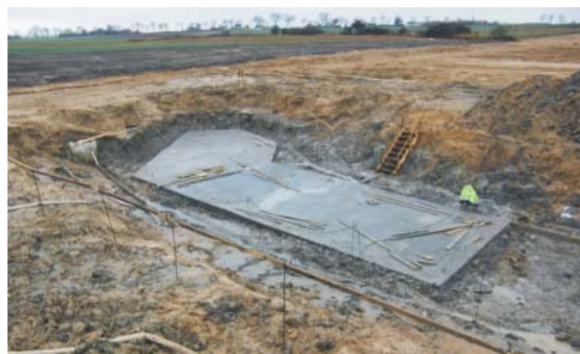
Fot. 4, 5. | Ułożenie chudego betonu na wcześniej wykonanych kolumnach DSM
