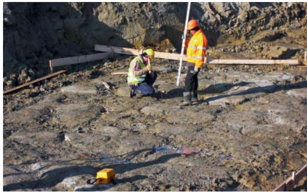
Fot. 3. | Pomiar geodezyjny wykonanych kolumn
