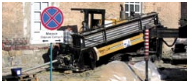
Fot. 7. Przewiert pod ulicą Partyzantów i potokiem Kamienickim w Bielsku-Białej
