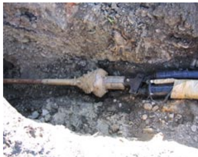
Fot. 4. Połączenie rur z głowicą
