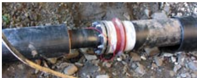
Fot. 6. Połączenie dwóch kabli
