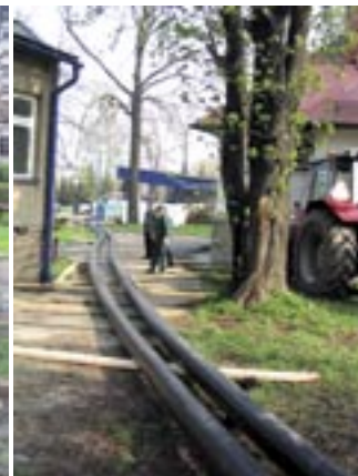
Fot. 2. Kabel przygotowany do przeciągania
