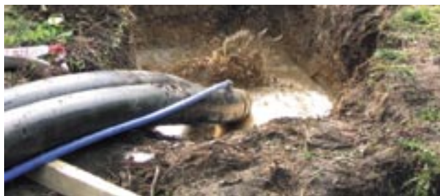
Fot. 5. Przeciąganie rur
