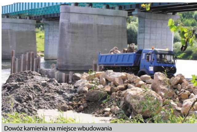
Dowóz kamienia na miejsce wbudowania
