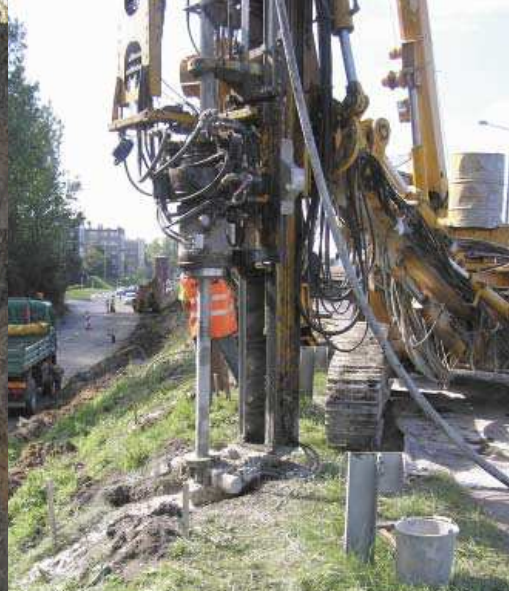
Fot. 2. Kolumny jet-grouting w skarpie zjazdu z wiaduktu
