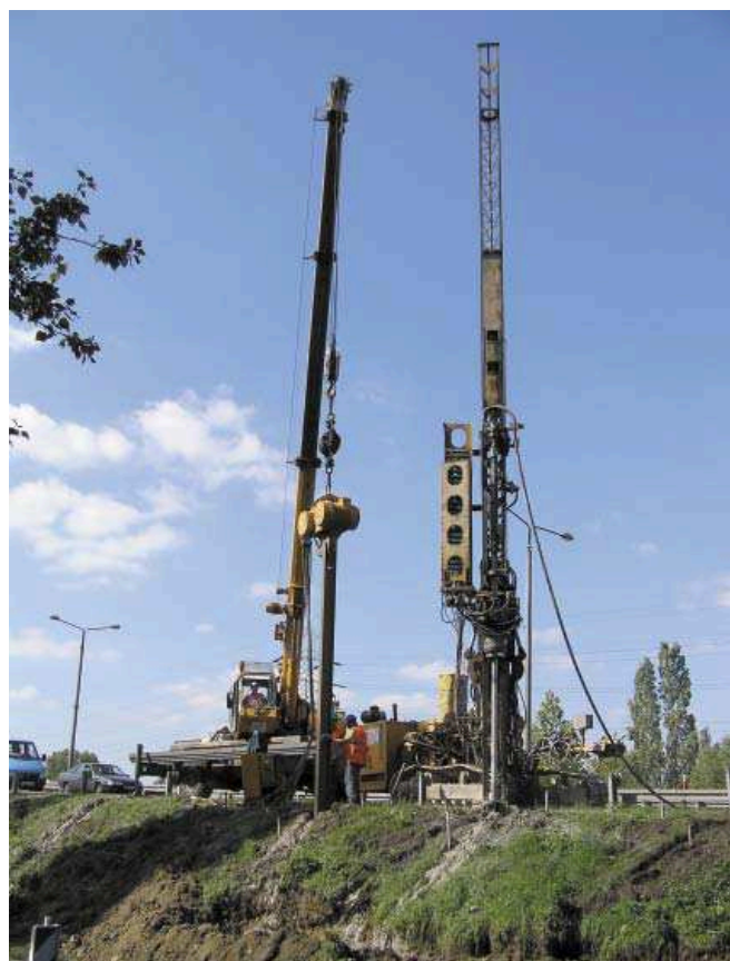
Fot. 5. Z lewej strony zabudowa zbrojenia przy użyciu wibromłota, z prawej – wykonywanie kolumny jet-grouting
