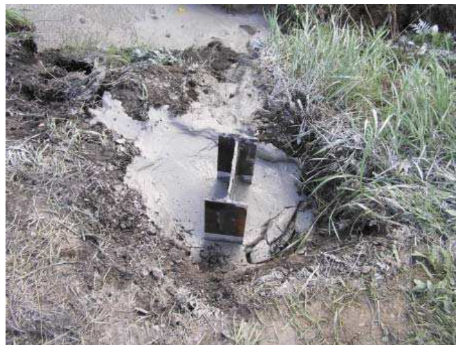
Fot. 4. Zbrojenie kolumny przed rozkuciem główki pala
