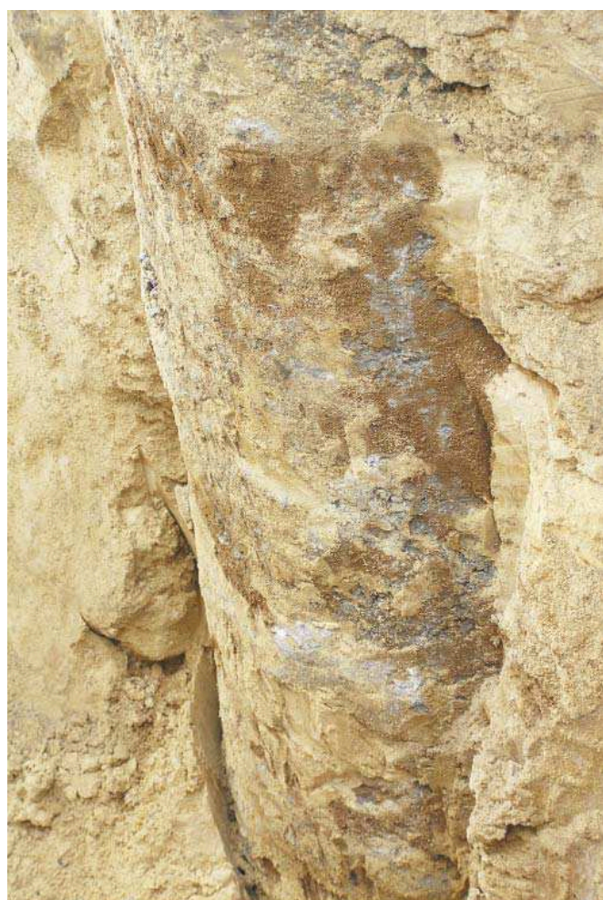
Fot. 3. Pal wiercony po wykonaniu odkrywki kontrolnej
