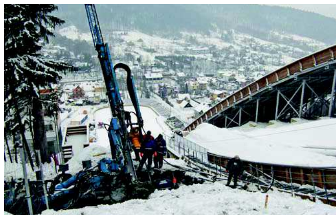
Fot. 4. | Wiertnica typu KLEMM podczas wiercenia mikropali
