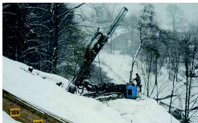
Fot. 3. | Wiertnica ustawiona na zboczu góry
