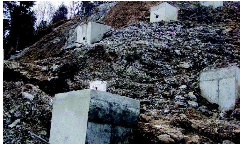
Fot. 5. | Zakotwione bloki fundamentowe skoczni K-40
