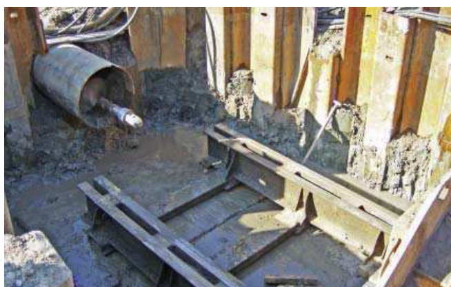
Fot. 4. Cofnięcie maszyny w celu motażu kolejnego odcinka rury
