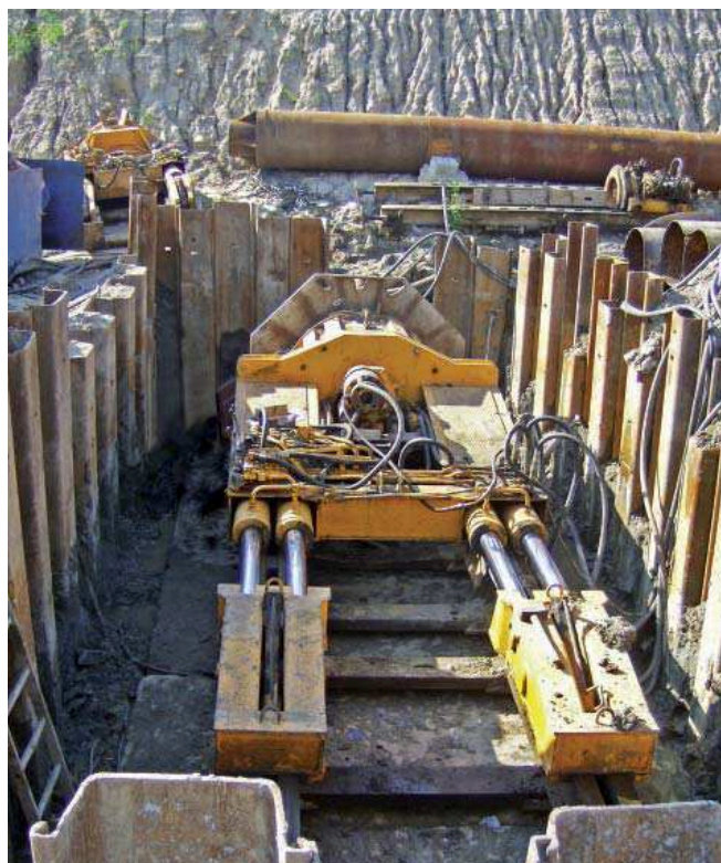
Fot. 1. Wiertnica do przewiertu poziomego – komora startowa
