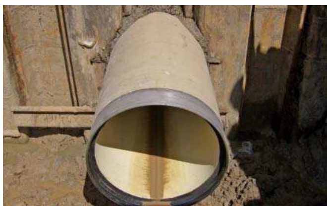
Fot. 3. Rura Hobas w komorze przewiertowej
