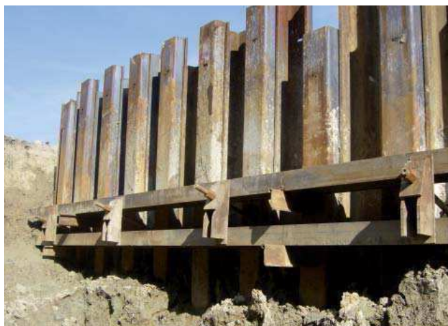
Fot. 5. Zabezpieczenie czynnego pasa DK nr 22 w celu wykonania przepustu DSR-1
