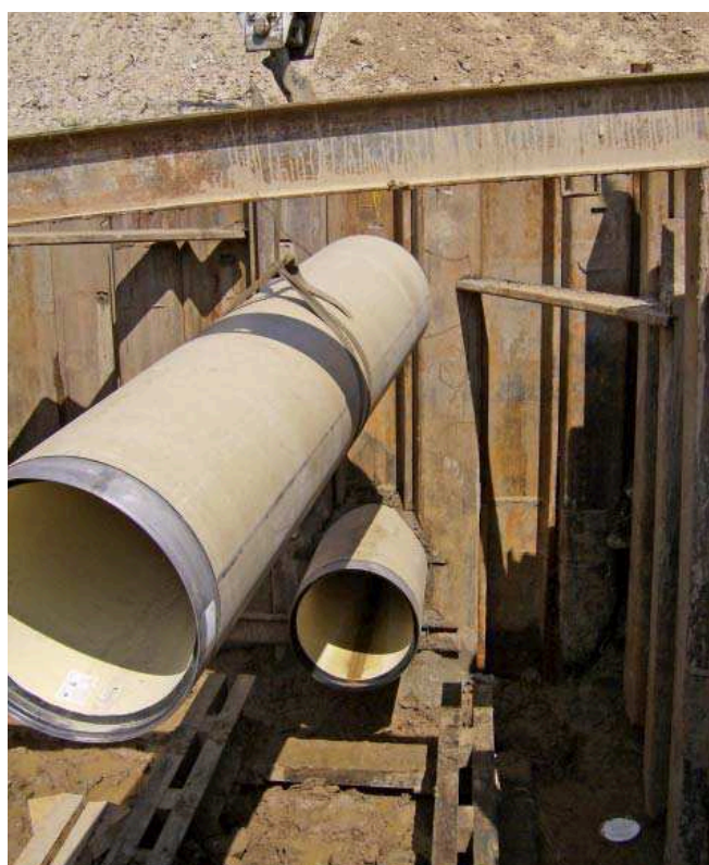
Fot. 2. Precyzyjny montaż rur z żywicy poliestrowych
