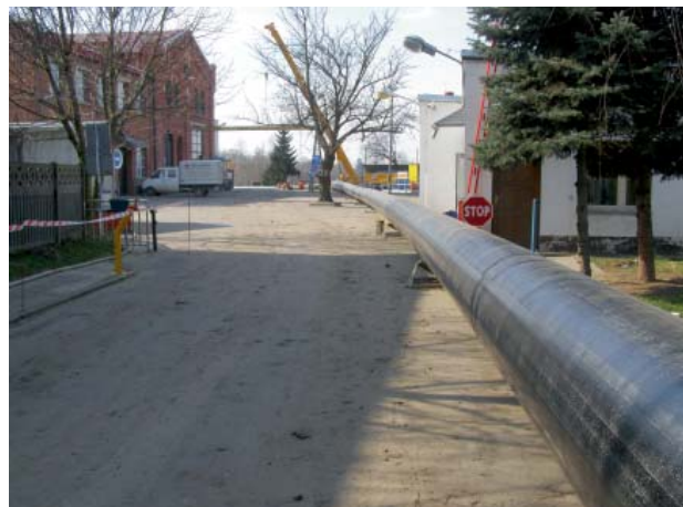
Fot. 5. Wciąganie rury polietylenowej 800 mm na rolkach
