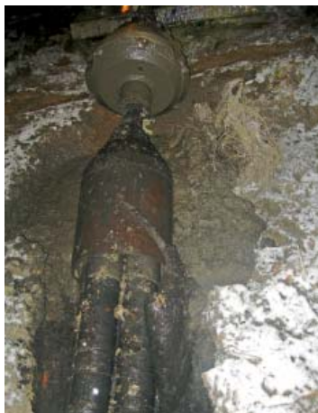
Fot. 4. Finał przewiertu 4 x 160 mm
