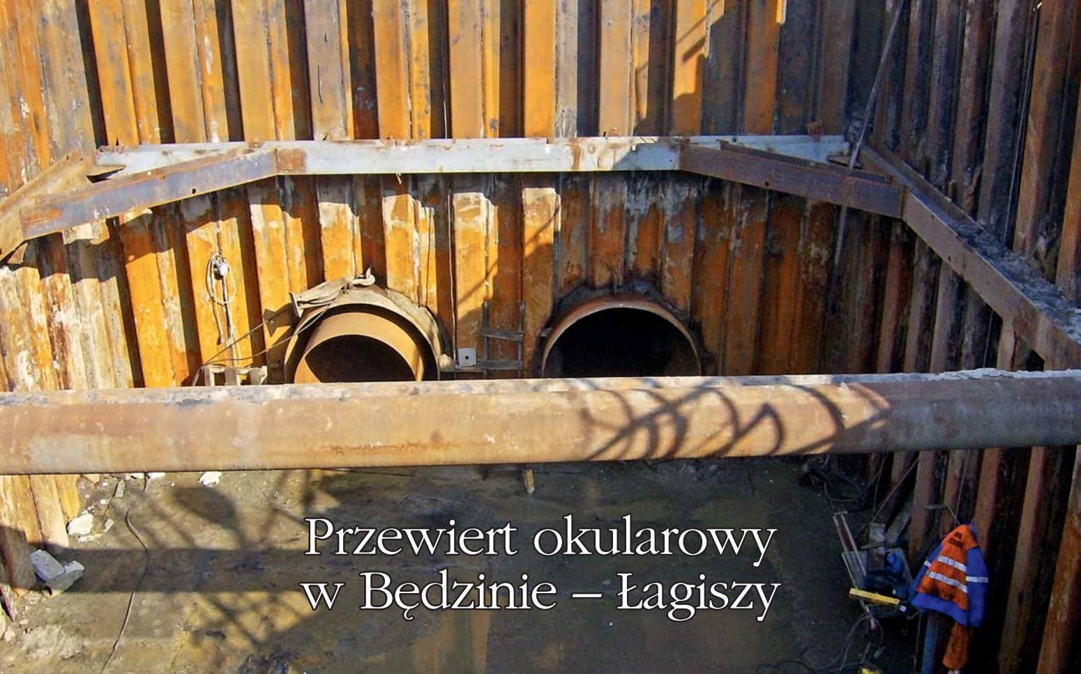
Fot. 1. Wykonane przewiert \phi 1820 mm
