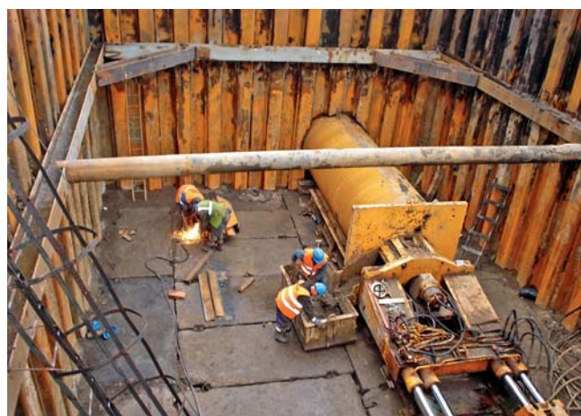
Fot. 3. Wykonanie pierwszego przewiertu
