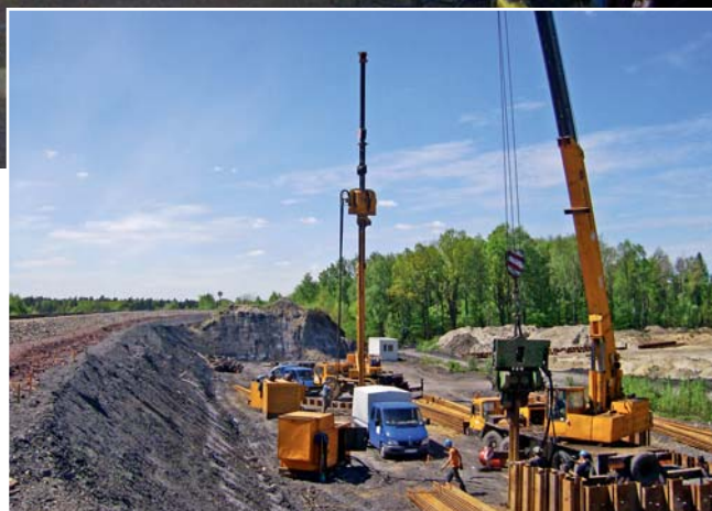
Fot. 2. Widok na plac budowy
