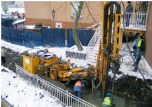
Fot. 3. Wiertnica KLEMM 806 formująca kolumnę o średnicy 1000 mm
