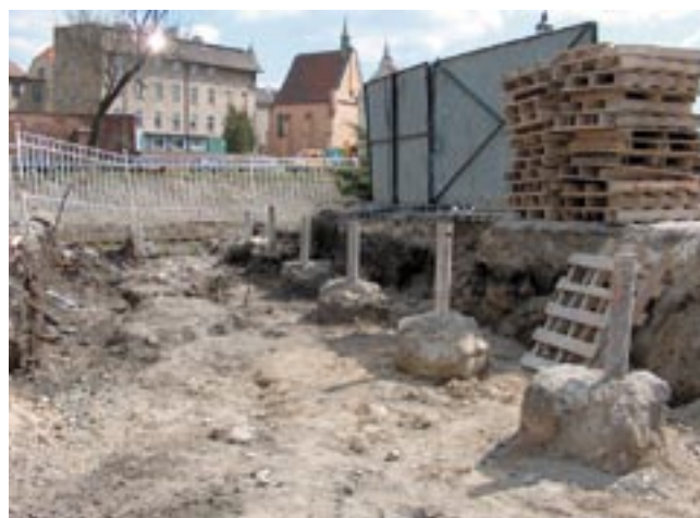
Fot. 1. Uformowane kolumny jet-grouting o średnicy 500 mm
