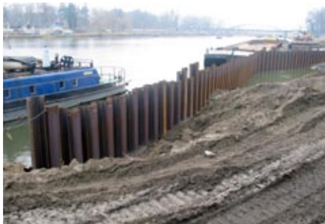
Fot. 5. Ścianka z grodzic G62 z dodatkiem Cu wbijana z barki
