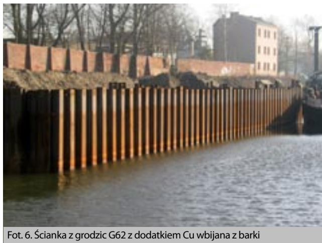
Fot. 5. Ścianka z grodzic G62 z dodatkiem Cu wbijana z barki
