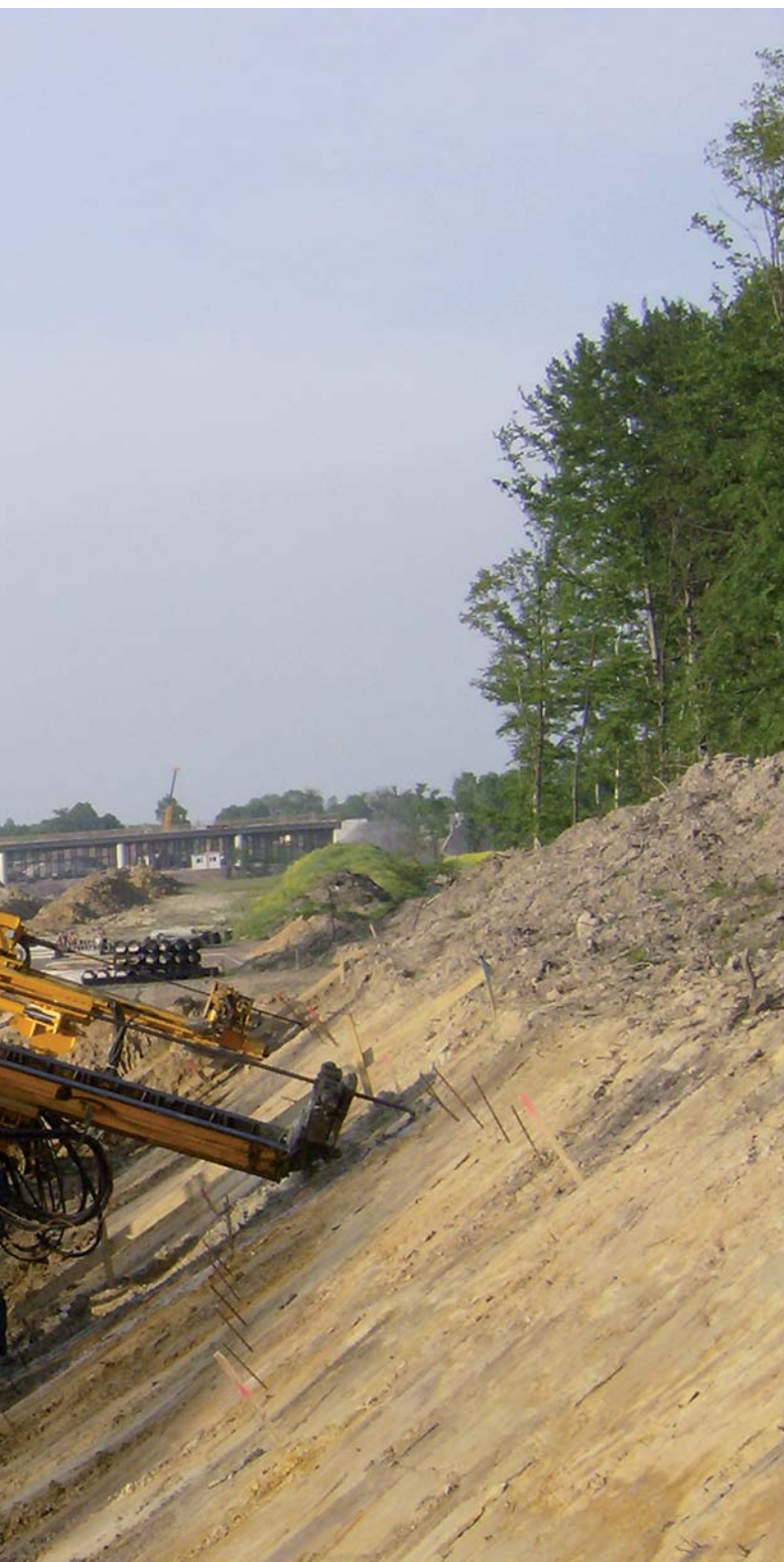
Skarpa z wykonanymi gwoździami gruntowymi oraz zamocowaną siatką
