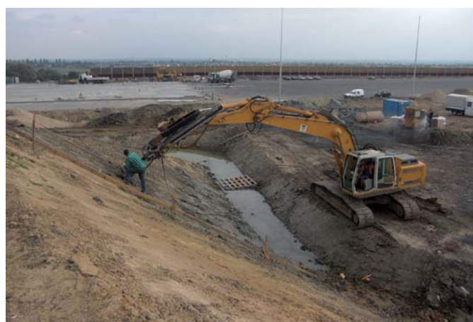
Wykonywanie gwoździ na wysokiej skarpie
