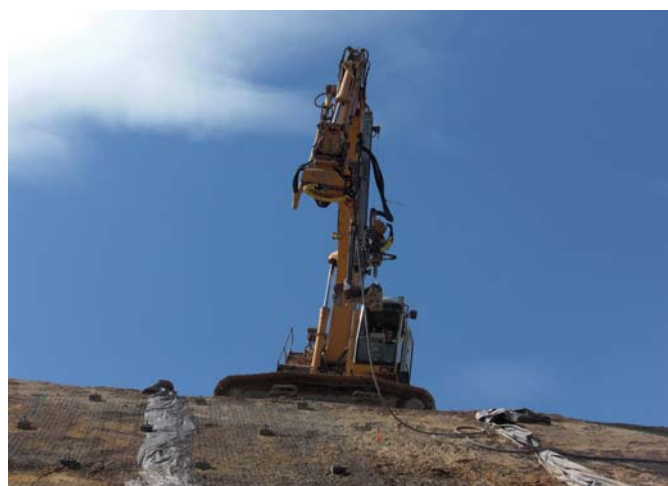
Skarpa z wykonanymi gwoździami gruntowymi oraz zamocowaną siatką
