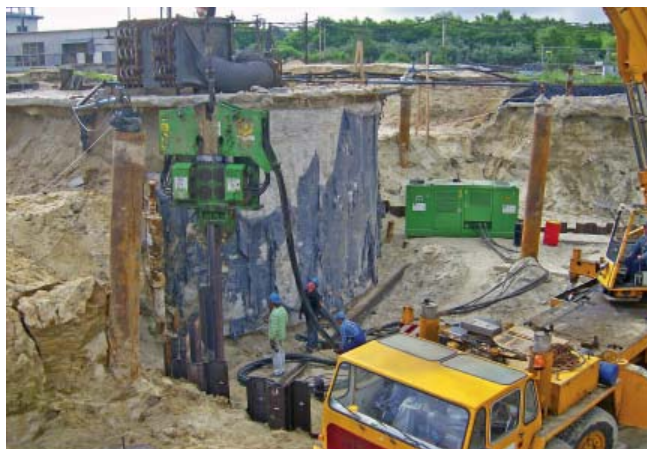
Fot. 4a, b. | Wbijanie grodzic GU16-400 wibromłotem wysokich częstotliwości drgań – ICE 28 Rf
