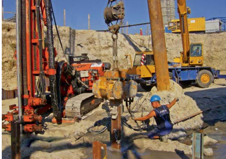
Fot. 2. | Montaż zbrojenia sztywnego w palach \phi 800
