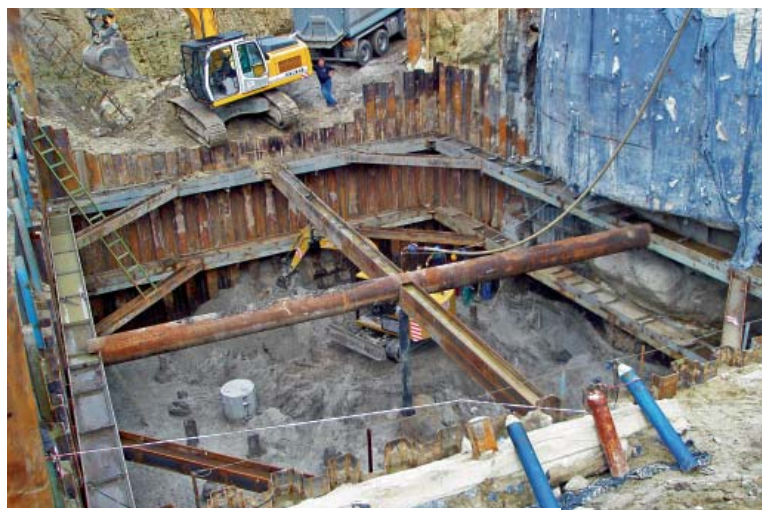
Fot. 3. | Komora z grodziec GU16-400 wraz z rozparciem
