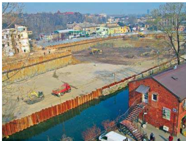
Fot. 7. Widok z dachu sąsiedniego budynku
