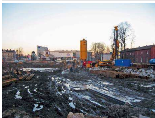
Fot. 4. Pogrążanie grodzic przy pomocy RT16G wraz z zestawem do iniekcji wysokociśnieniowej
