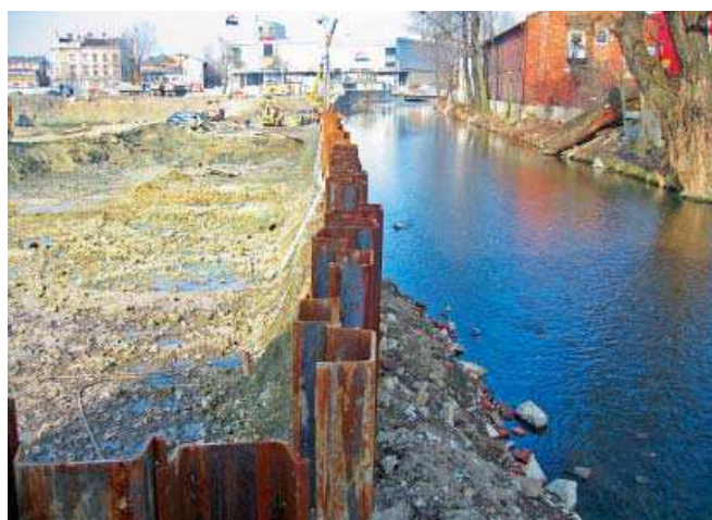
Fot. 1. Zabezpieczenie wykopu wzdłuż rzeki Białki
