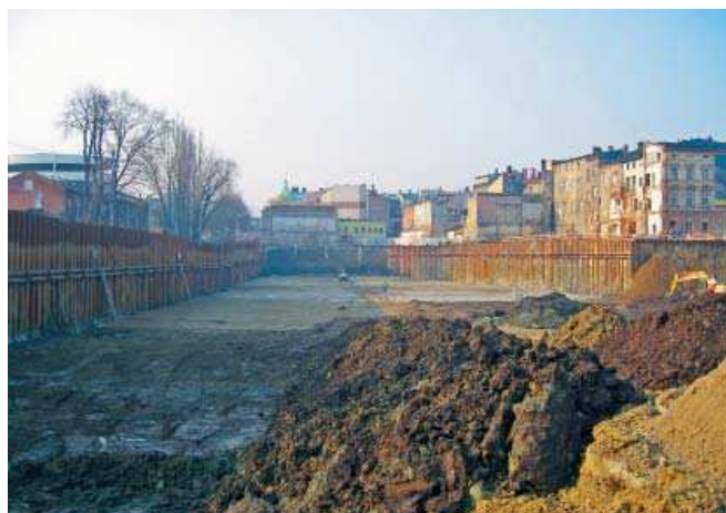
Fot. 2. Przygotowanie placu budowy dla prac fundamentowych
