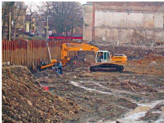
Fot. 6. Postęp prac od strony rzeki Białki – kotwienie ścianki, z tyłu palisada jet-grouting
