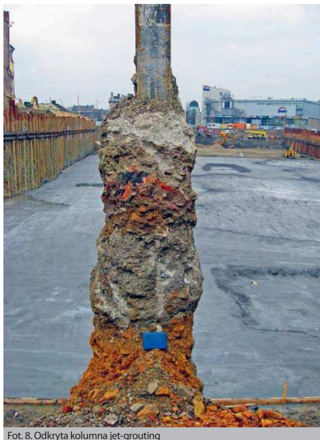
Fot. 8. Odkryta kolumna jet-grouting
