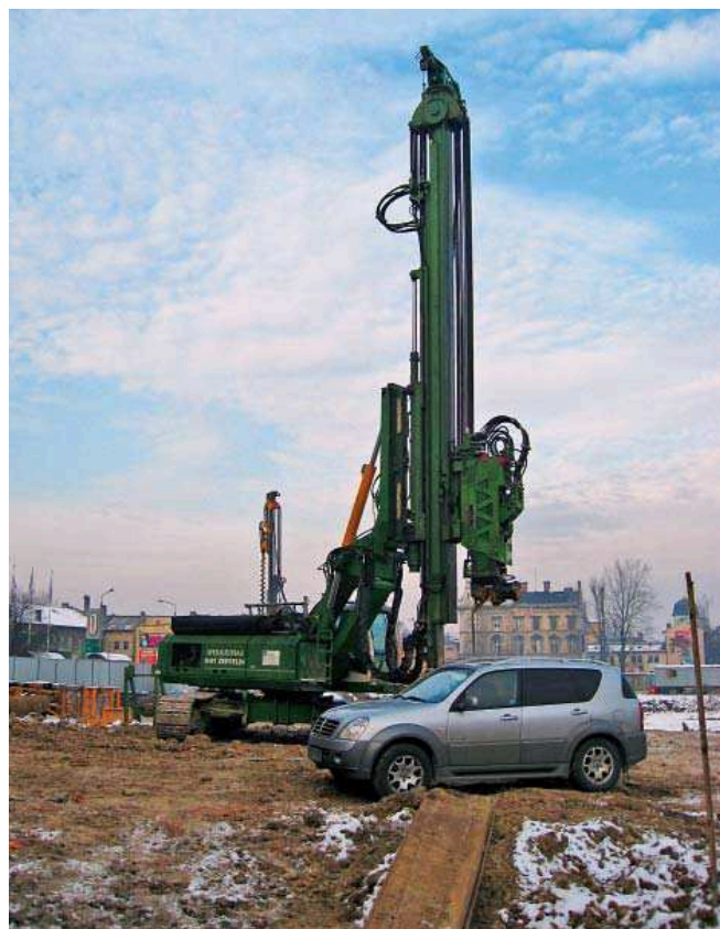
Fot. 3. Wiertnica RT18G uzbrojona w wibromłot – w tle modyfikacja gruntu wiertnicą RT16G
